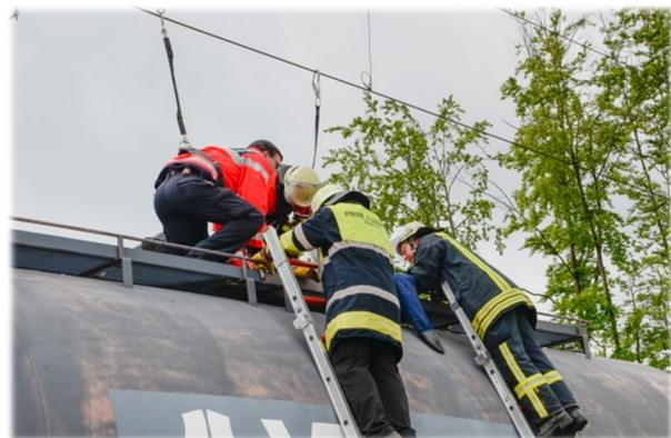
Abbildung 22: Sicherung an der geerdeten Oberleitung
